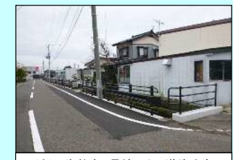
(市)田海仲島1号線ほか 道路改良 (基幹事業 道路)
