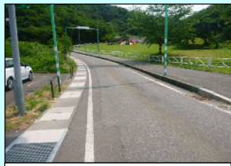
(市)三峯線 側溝改修 (基幹事業 道路)
