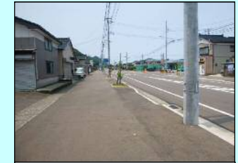
(市)青海通線 歩道改修 (基幹事業 道路)
