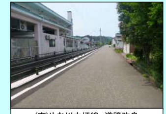
(市)めな川大坪線 道路改良 (基幹事業 道路)
